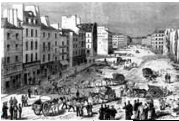
Les grands travaux de Paris. Percement du boulevard Saint-Germain en 1877
