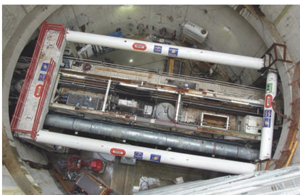
Assemblage du tunnelier
