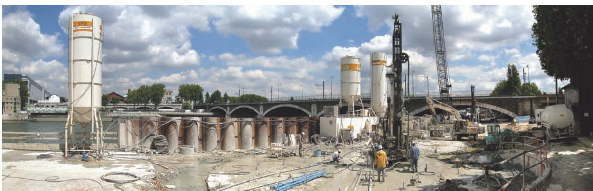
Travaux d'injection des puits Masséna
