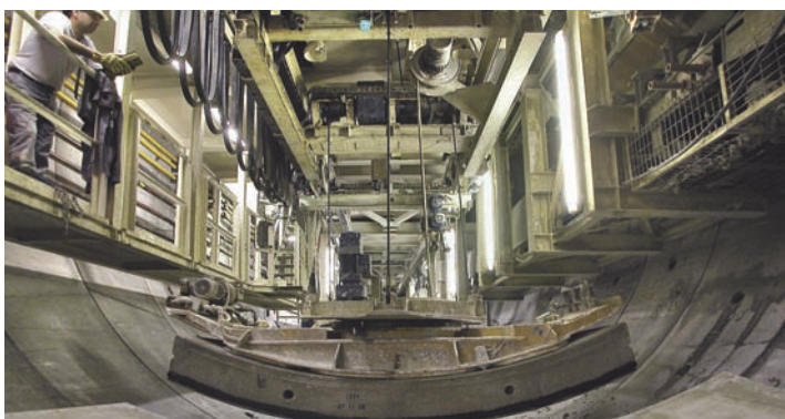
Système de voussoirs mis en place au fur et à mesure de l'avancée du tunnelier
