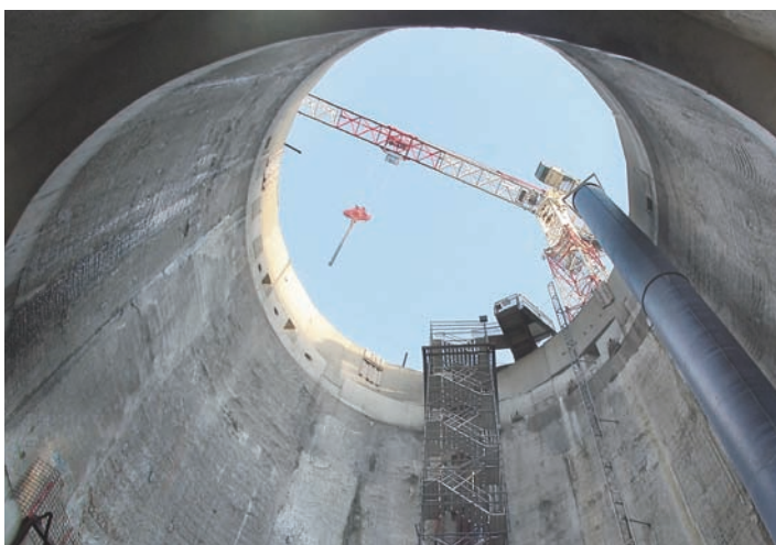
Construction du puits Masséna
