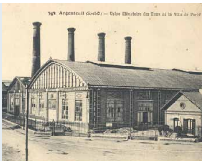
Figure 39 : Carte postale de l'usine élévatoire des eaux de Colombes
