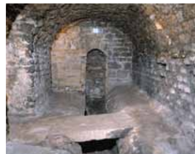
Figure 7 : Le canal de l'égout des thermes de Cluny Thermes gallo-romains de Cluny : canal de l'égout longeant les thermes à l'ouest, en sous-sol, époque gallo-romaine (50 av. J.-C.-100 ap. J.-C.). Paris, musée national du Moyen Âge - Thermes de Cluny
