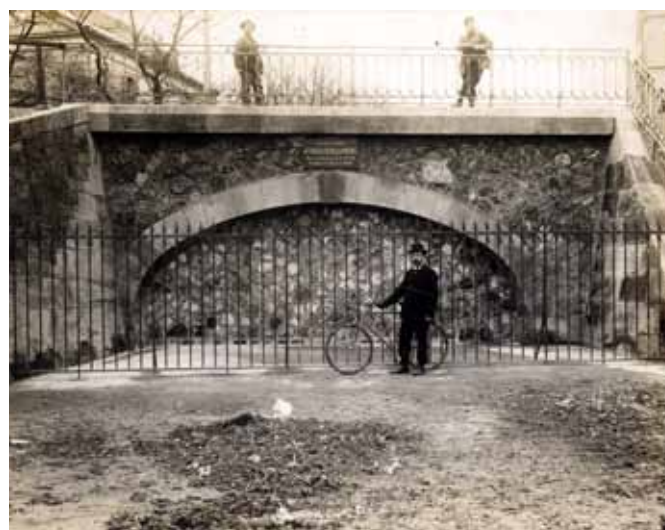
Figure 44 : Fermeture de l'exutoire du collecteur de Clichy-Asnières en 1899
