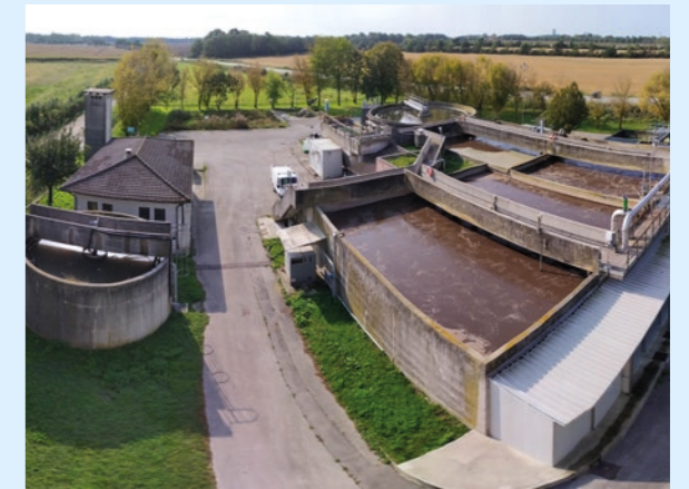
Usine d'épuration équipée de traitements avancés (acide performique) - Venise
