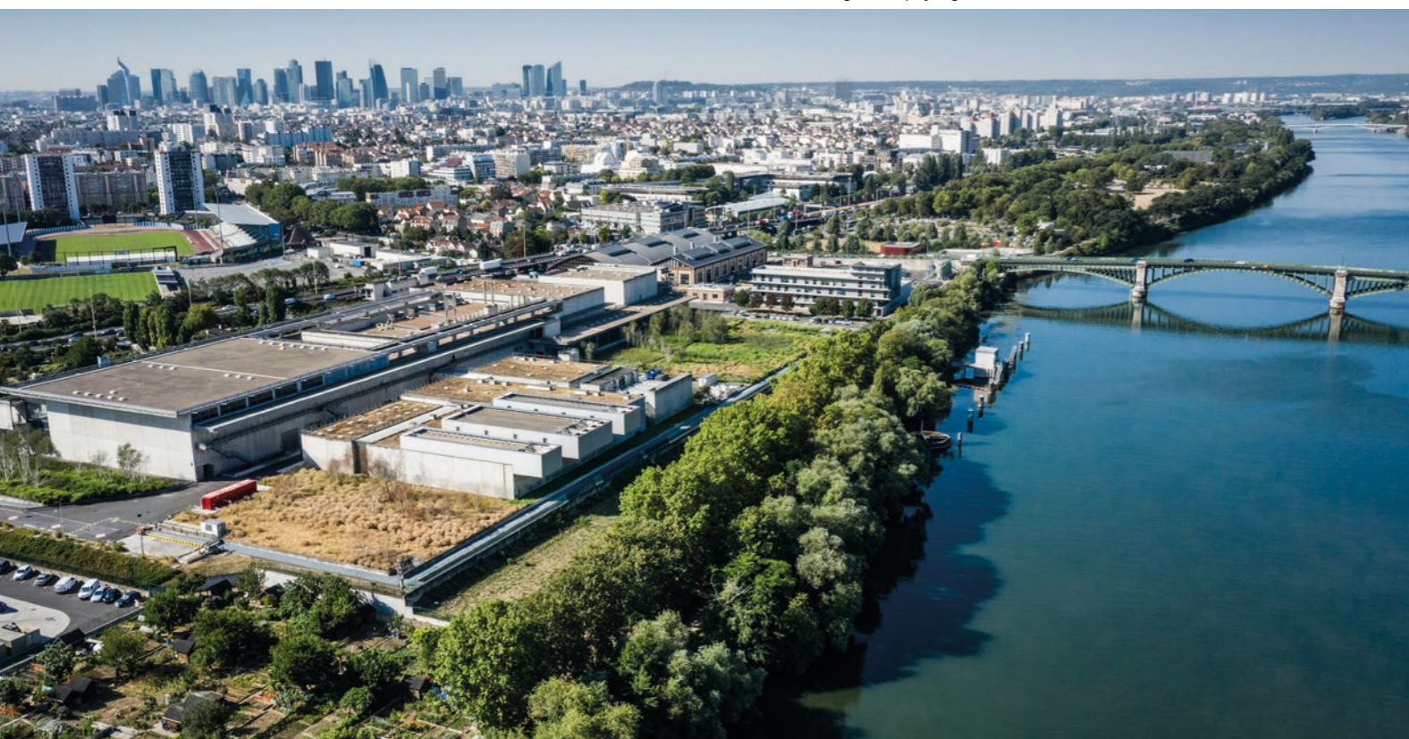
Usine Seine centre intégrée au paysage urbain
