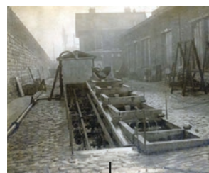
Essais d'épuration biologique par filtres biologiques
