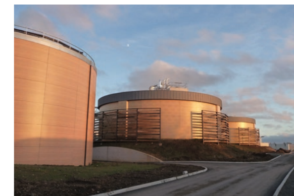
Digesteurs - Seine Grésillons
