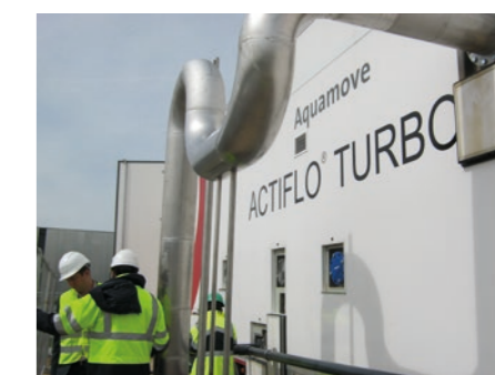
Couplage décantation physico-chimique - charbon actif (Veolia)
