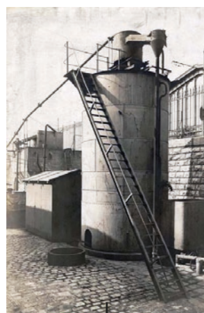
Essais d'épuration biologique par boues activées
