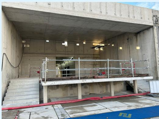
Les travaux de gros-œuvre sont à présent achevés. Le dernier local en cours de finalisation est la salle de commande de la clarifloculation dont une partie de l'ouvrage se trouve en porte-à-faux sur le parvis des décanteurs.
