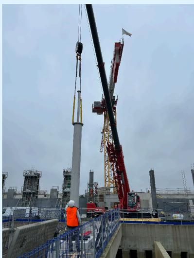
Afin d'évacuer les boues issues de la phase de décantation, des racleurs sont en cours d'installation dans les ouvrages.
