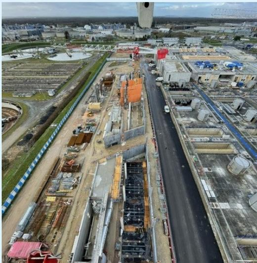
Les dalles support des cuves de chlorure ferrique sont en cours de coffrage et de ferrailage. Elles sont dimensionnées pour supporter des cuves d'un poids unitaire de 180 tonnes lorsqu'elles seront totalement remplies.
