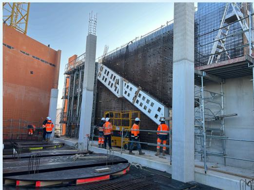
Les travaux de génie civil se poursuivent avec la création des dalles de supportage des cuves et des escaliers permettant d'accéder à la passerelle qui desservira les locaux électriques du premier étage.
