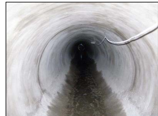
Etat après travaux
