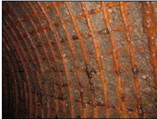
Etat des parements avant travaux
