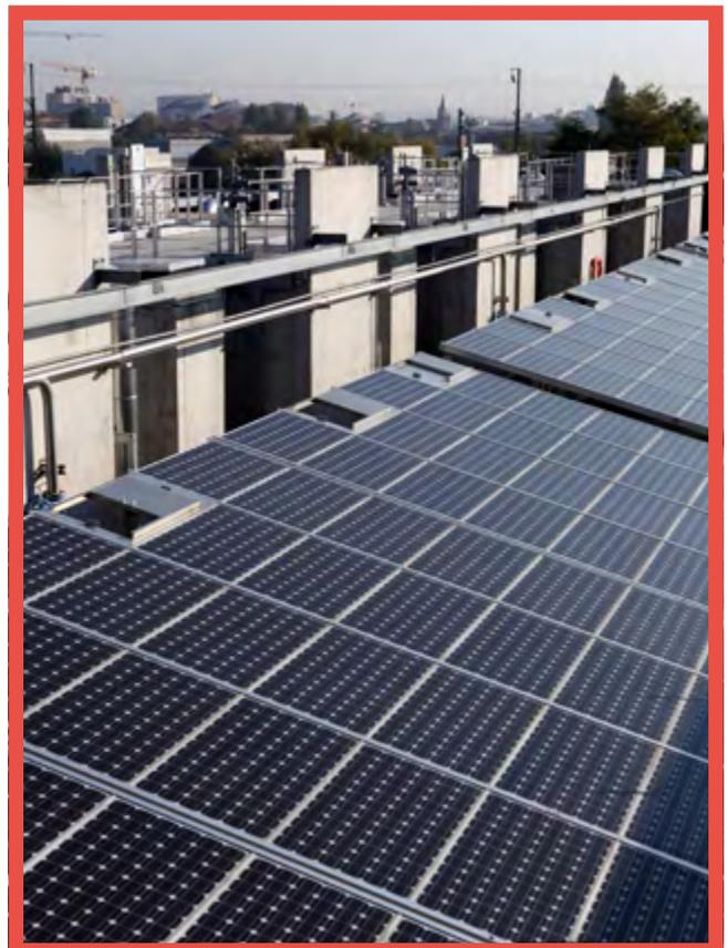
Panneaux photovoltaïques disposés sur la toiture des bassins de biofiltration.
