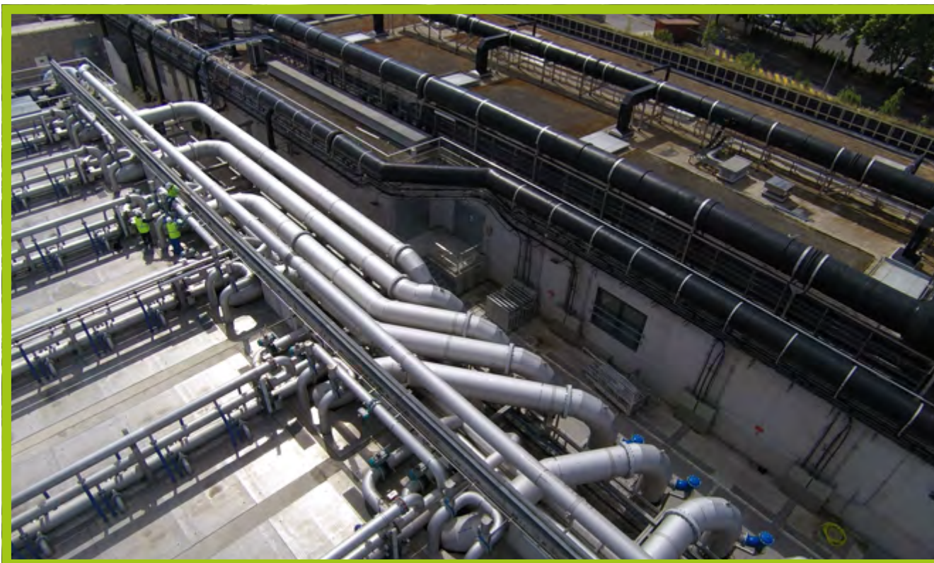
Vue aérienne du toit de l'usine.
