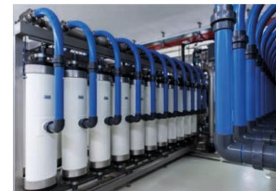
Traitement membranaire en eau potable - Usine de Lutry
